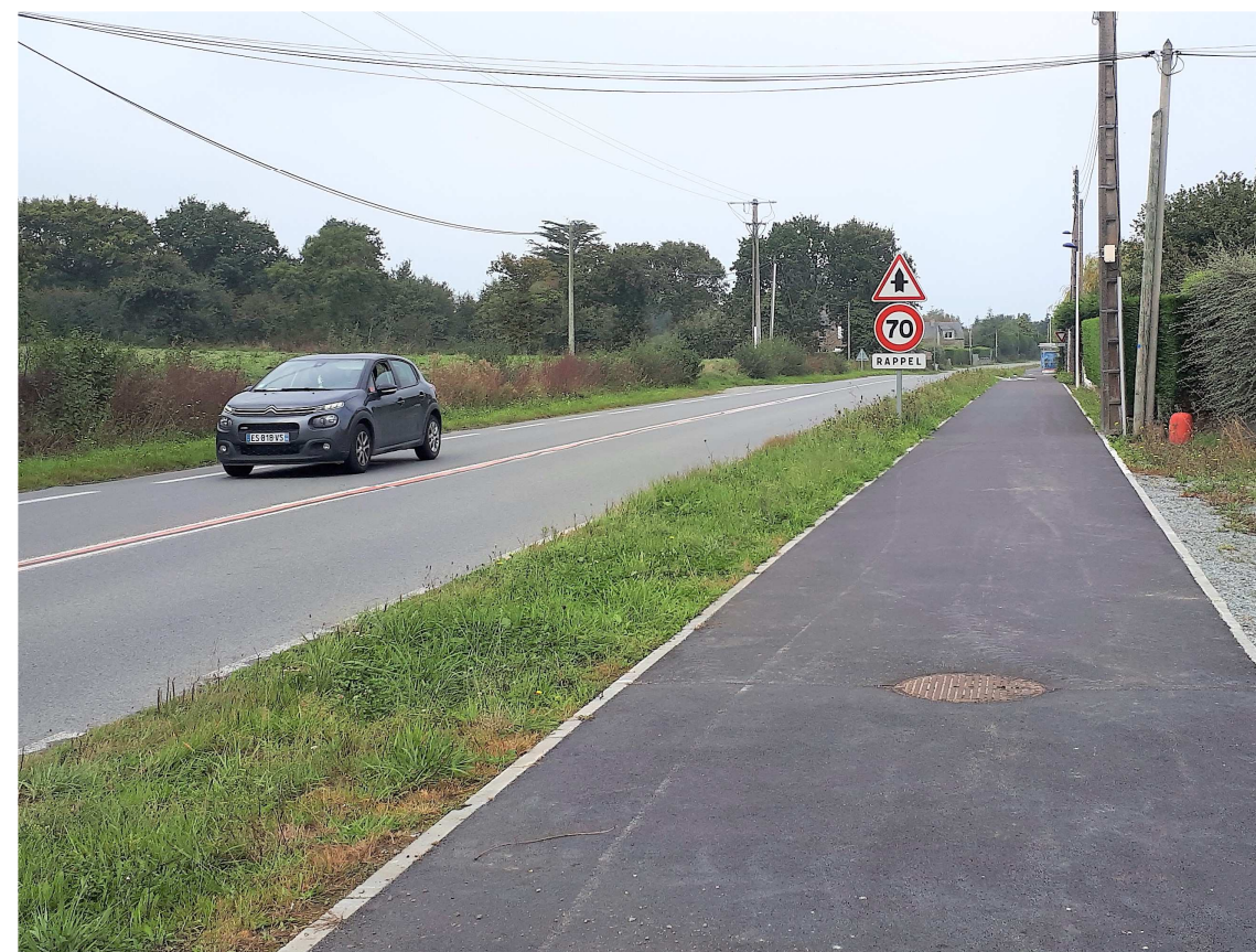
La piste cyclable bidirectionnelle réalisée au Nord du carrefour de la Rabine pendant l'hiver 2019-2020
