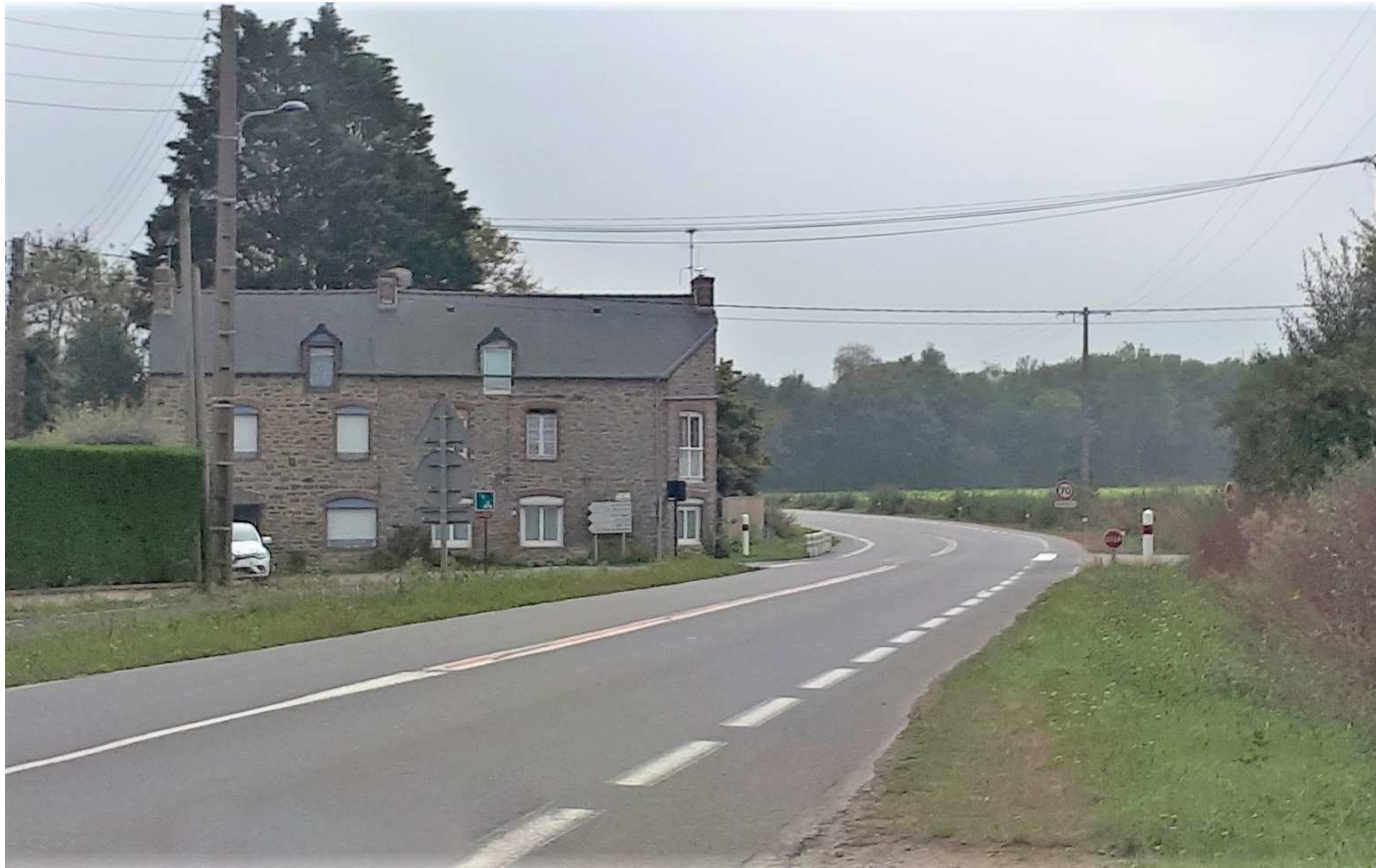
Un bâti proche, qui masque la visibilité au débouché de la voie communale, et un carrefour en sortie de courbe sont les principales sources de l'accidentologie
